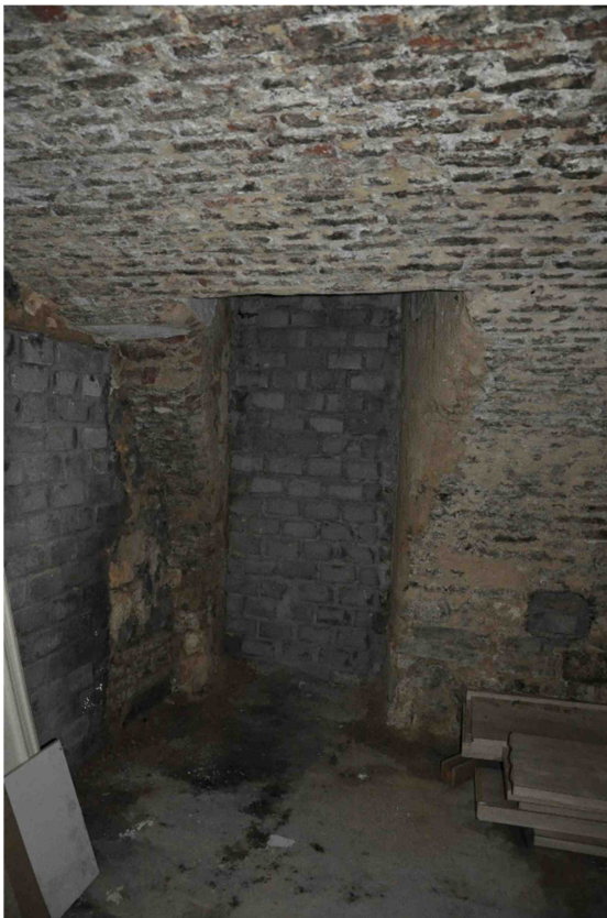
14 dichtgezette doorgang in westelijke richting
